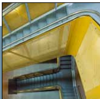
Lamiere con foratura tonda e verniciate a polvere rivestono la tromba delle scale della Torre Bismarck (Dresda – Germania). Grazie alla bordatura su misura, le lamiere possono essere montate senza problemi alla struttura portante.
