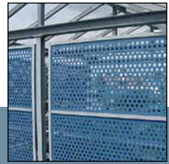
Lamiera forate zincate utilizzate per un parapetto di sicurezza all'interno di un centro commerciale. Caratteristiche tecniche: spessore 20/10, foro tondo, zincatura a caldo, verniciatura a polvere.
